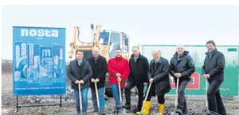
Die Firma Nosta errichtet auf dem Areal An der Bahn 5 in Höchstädt eine Produktions- und Lagerhalle. Zum ersten Spatenstich trafen sich (von links) Geschäftsführer Josef Hertle von der Krätz Bau GmbH; Wolfgang Häußler, Krätz Bau; Betriebsrat Stefan Probst, Nosta; Josef Kapfer, Nosta; Bernhard Miller, Firma Alois Miller Blindheim; Manfred Krafft, Firma Traub Aalen. Foto: Pawlu
