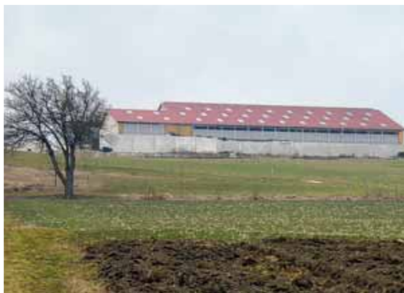
Neben diesem Milchviehstall am Rande von Zöschingen soll bald eine 42 Meter lange Halle entstehen. Das gefiel nicht allen Gemeinderäten. Foto: Haas
