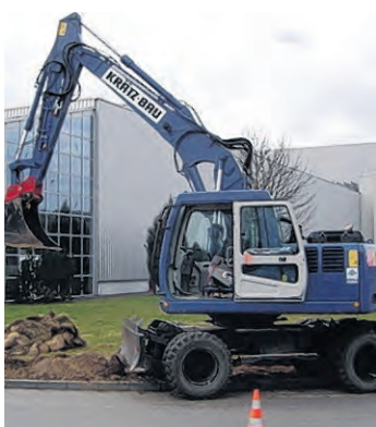
Sie sind in der Region häufig im Einsatz: Die Bagger von Krätz-Bau.
