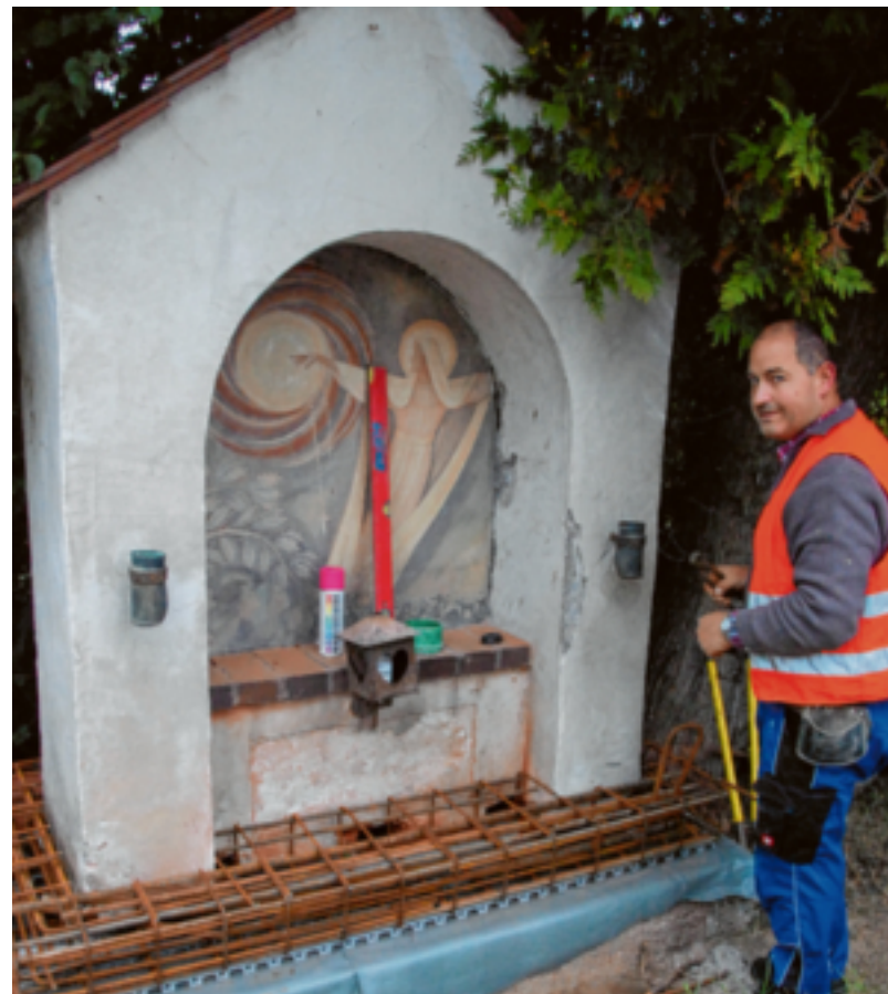
Seitenwechsel: Der Marienbildstock an der Donauwörther Straße in Dillingen wechselt die Straßenseite. Er wird beim Berliner Bären aufgestellt. Die Firma Krätz-Bau (auf dem Foto Mitarbeiter Jürgen Steinwinter) versetzt den Bildstock. Foto: Veh
