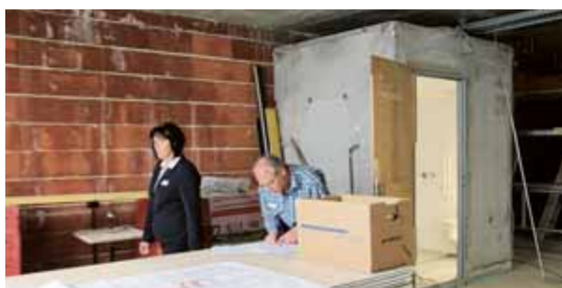
Betriebsdirektorin Barbara Jahn-Hofmann und technischer Leiter Karl Scheuenpflug auf der Baustelle.
