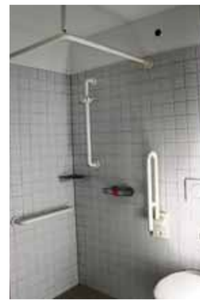
Im ersten und zweiten Stockwerk des neuen Traktes sind insgesamt 18 Fertig-Nasszellen schon eingebaut.
